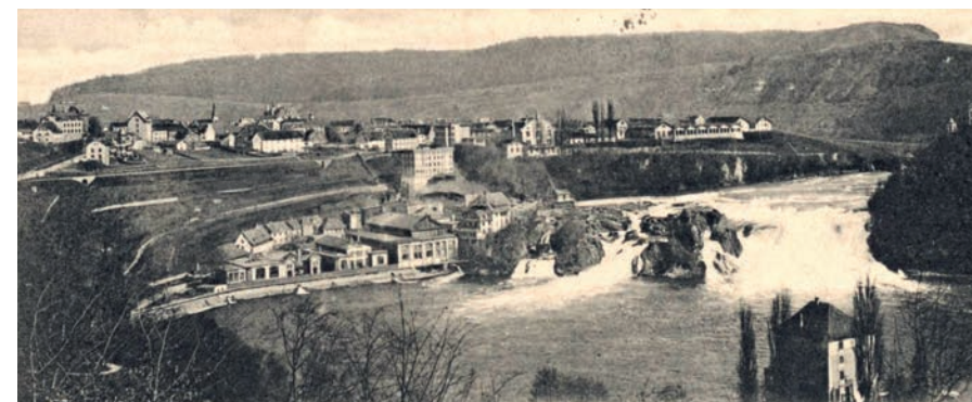
Rheinflall um 1900 mit Wasserkraftwerk und Industrieanlagen
