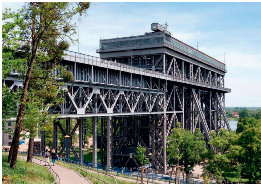
Zum Vergleich: Das am 21. März 1934 in Betrieb genommene Schiffshebwerk Niederfinow überwindet einen Höhenunterschied von 36 Metern. wikipedia.org
