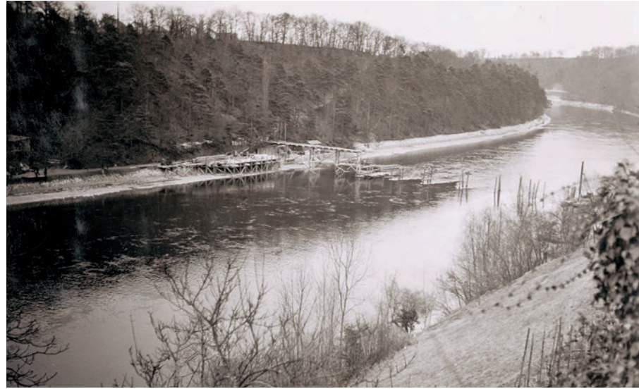
Bau des Betonsteges. Vor diesem Bau war das Nohl bis 1956 nur mit der Fähre von Dachsen aus erreichbar. Auf diesem Bild sind bereits die Uferverbauungen ausgeführt, damit der Rhein, wegen der Staumauer in Rheinau, bis zum Rheinfall aufgestaut werden konnte. (Foto: Ernst Mändli)
